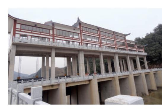
通山县涓港拦河闸位于通山县通羊镇焦岩村,是一座具有灌溉、供水、防洪和发电等综合利用的大型水闸工程。
