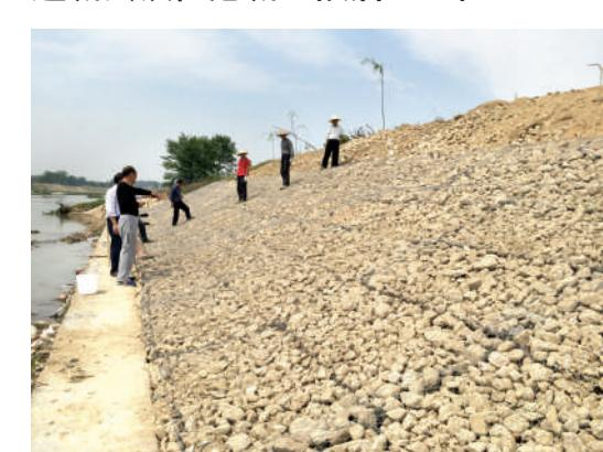
通城县铁柱港城区段治理工程治理范围为铁柱港下畈桥至铁柱大桥段,治理河长7.0公里。该治理范围河段存在河道淤塞、部分堤防堤顶欠高、部分岸坡不稳定等问题。
