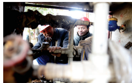
25日,咸宁联合水务有限公司技术人员在原地区毛巾厂宿舍更换冻坏水阀。记者 袁灿 摄
