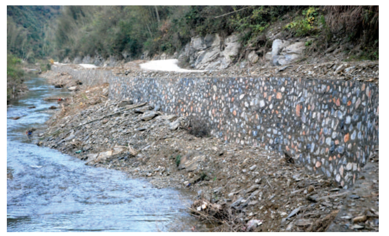
灾后新修的河堤
