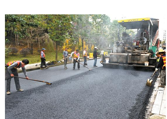
21日,城区谭惠路,市安达公路养护公司施工人员正在刷黑道路。谭惠路、交通路、牛街这三条道路的维修刷黑工程是2015年度市委市政府重点工程,施工总里程2.47公里。全部完工后,将有效改善城区道路的通行能力,进一步提升香城泉都的城市形象。
