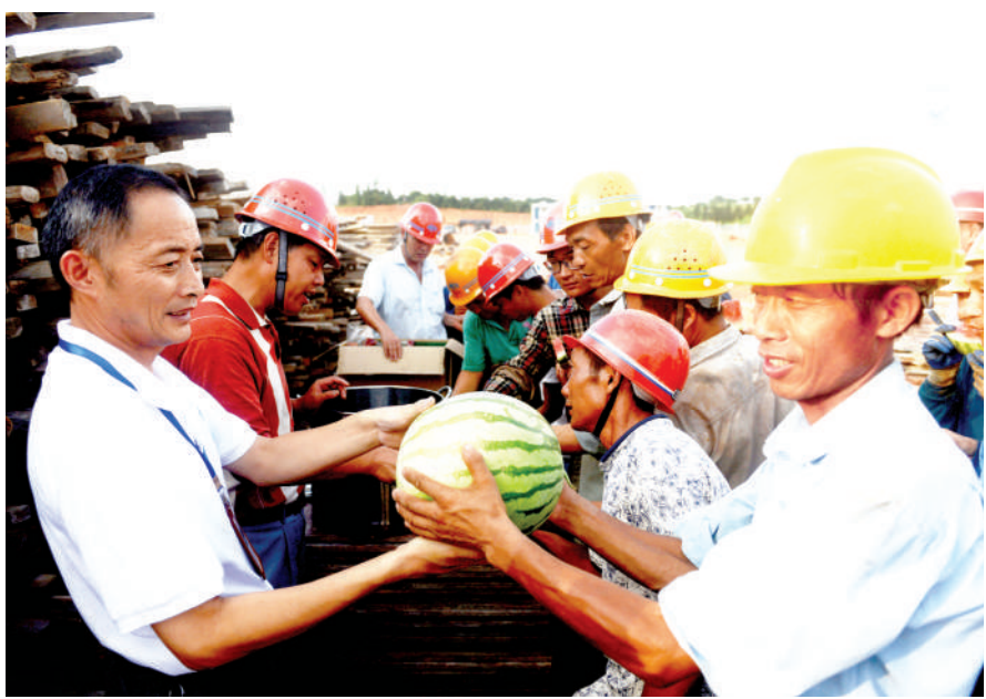
5日,咸宁联合水务有限公司员工深入王英引水建设工地,将西瓜、饮料等送给一线工人。 记者 袁灿 通讯员 徐武勇 摄
