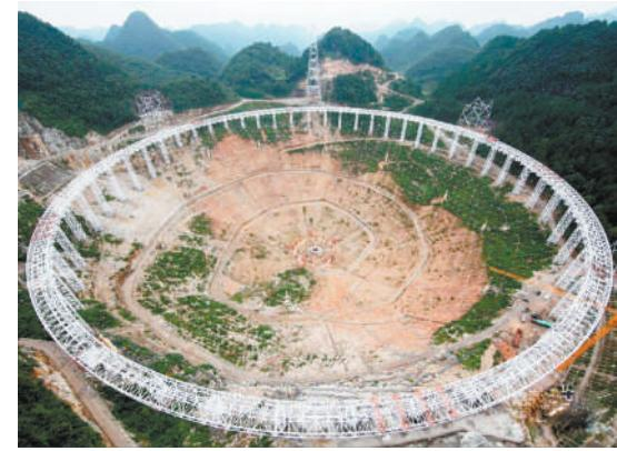
正在中国贵州黔南安装建设的500米口径球面射电望远镜(英文简称:FAST),是目前世界上在建的口径最大、最具威力的单天线射电望远镜。中国FAST工程办公室称,这一超级望远镜有望在2016年建成,建成后将成为世界级别的天文研究中心。
