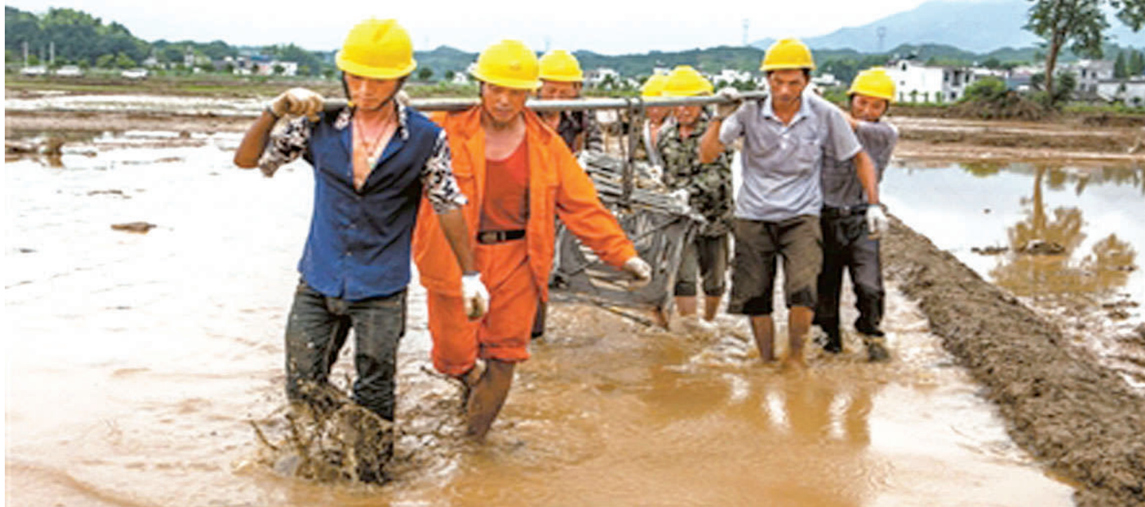
崇阳县供电公司职工正在抢修线路
