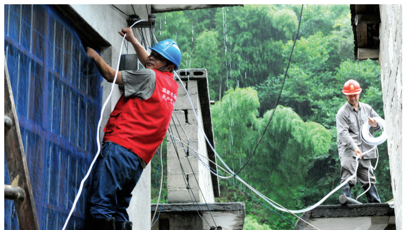
施工人员冒雨抢架线路
