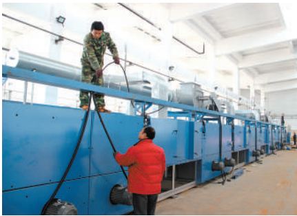
嘉麟杰车间设备安装
