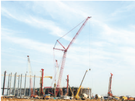
金盛兰项目施工现场
