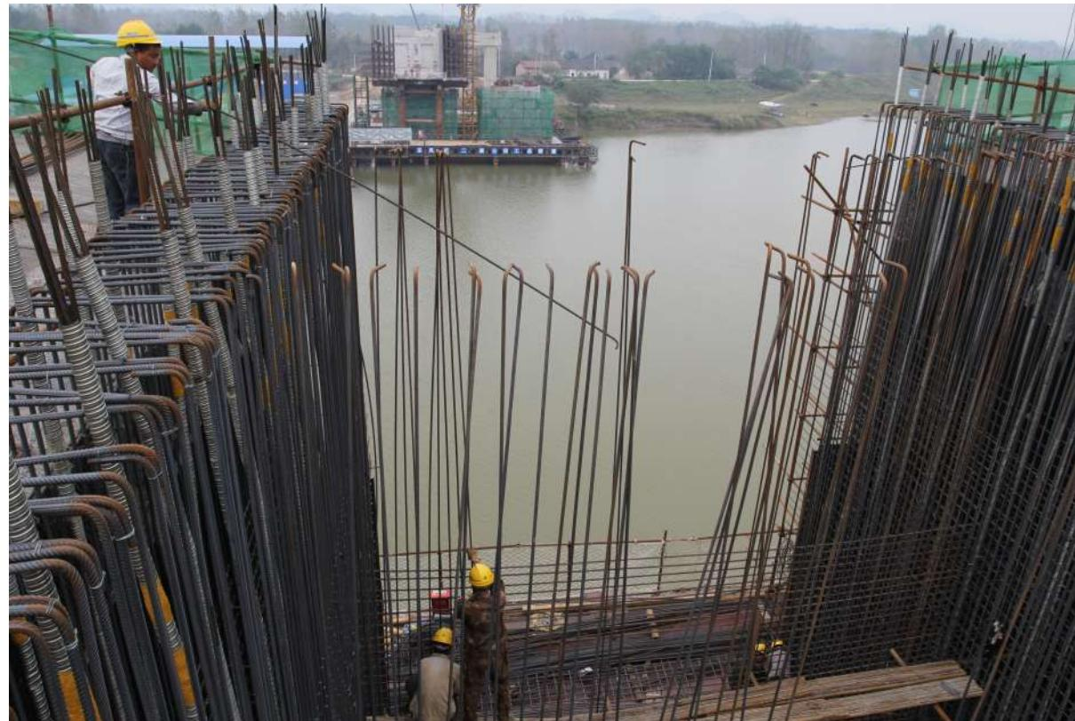
16日,记者在武深高速公路嘉通段陆水河特大桥看到,工人们正在进行钢筋绑扎施工。作为武深高速公路嘉通段最长的桥梁,该桥由湖北中交嘉通高速公路发展有限公司以BOT+EPC形式施工建设,是全线重点控制性工程之一,造价2.8亿元,全长1728米,大桥预计于2015年10月底合拢。
