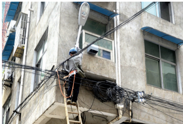
为背街小巷安装路灯
