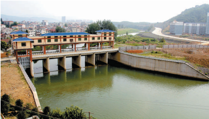
日前,从市水务局传来消息,咸安区大畈陈拦河闸已投入使用。该闸投资4240余万元,建筑物防洪标准按50年一遇设计,可进一步提高淦河防洪能力,并有效改善水生态环境。 通讯员 王甫润 摄
