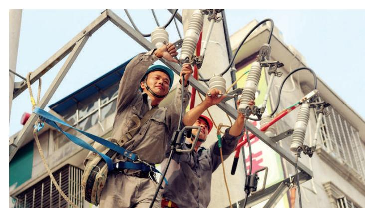
8月2日凌晨,通城县供电公司银山电业施工人员为10千伏城北2#线步行街变压器增容。增容后,沿线337户居民将摆脱低电压困扰。
