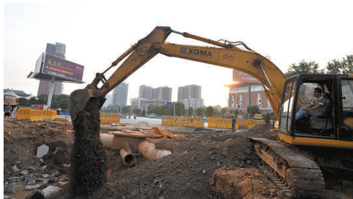
7月26日,咸宁大道与贺胜路交叉处,大型挖掘机正在作业。
