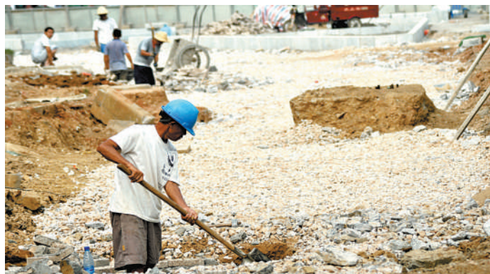
7月27日,金桂路与长安大道路口,工人们正在开挖沟槽。
