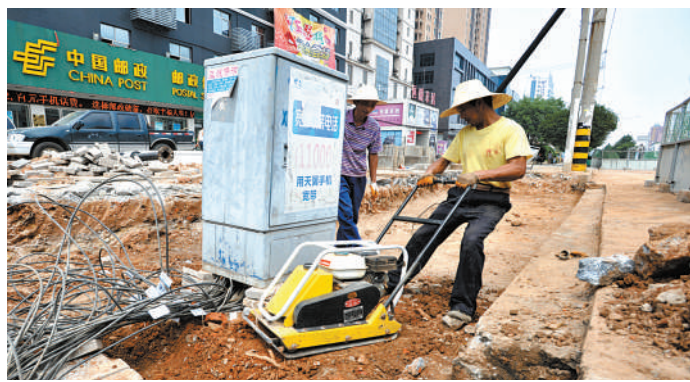
7月26日,交通路口,工人们正在平整路基。
