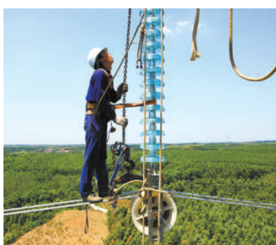
架设220千伏横宝线。
