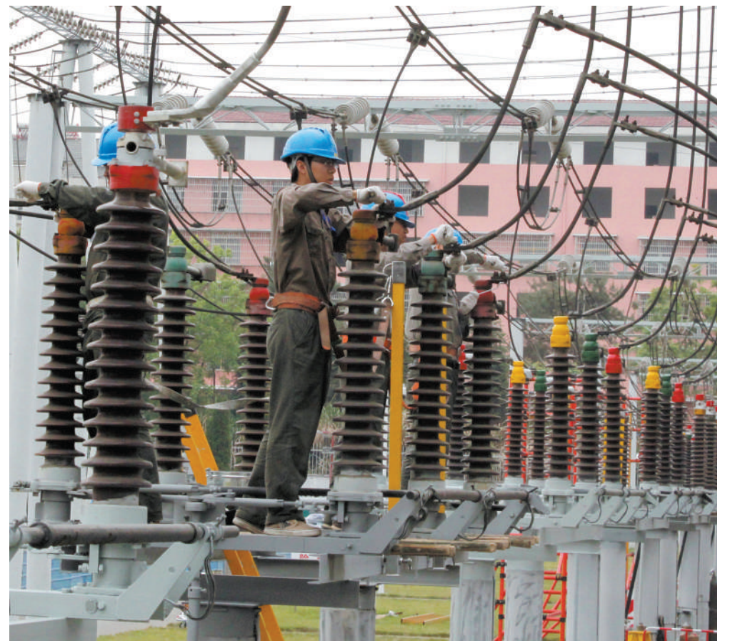
国网咸宁供电公司员工在检修220千伏汪庄余变电站设备。
