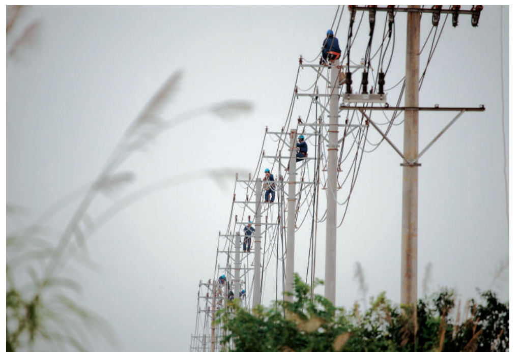
国网咸宁供电公司员工为南玻集团架设10千伏专用配电线路。
