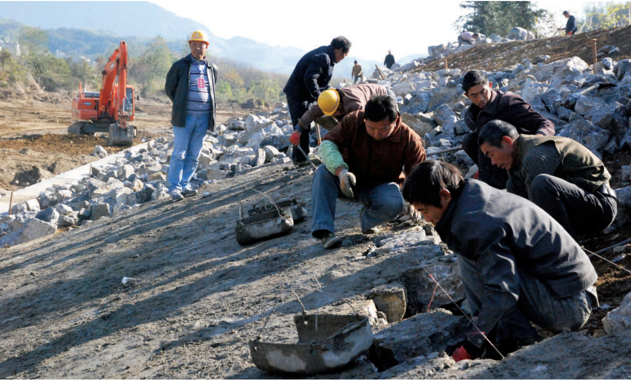
高堤河流经崇阳金塘、港口和白霓三个乡镇，河道长60公里，流域面积596平方公里，由于年久失修，该河道堤身单薄，堤顶欠高，岸坡冲刷，淤塞现象严重。图为11月28日，港口乡张家湾段进行土堤加固和砌石护坡的情景。 特约记者 马丽娅 通讯员 陈地牡 摄
