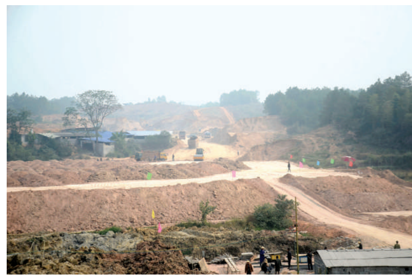
丰日大道建设现场
