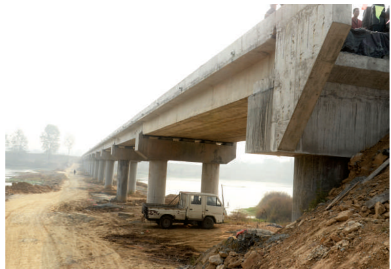
在建的白马大桥
