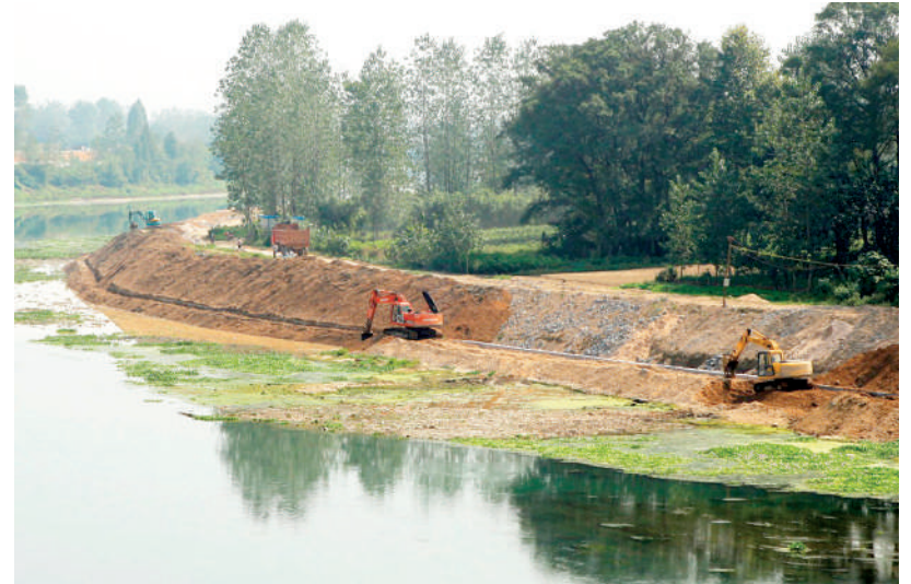
建设者加班加点推进天城公园南岸防洪堤建设
