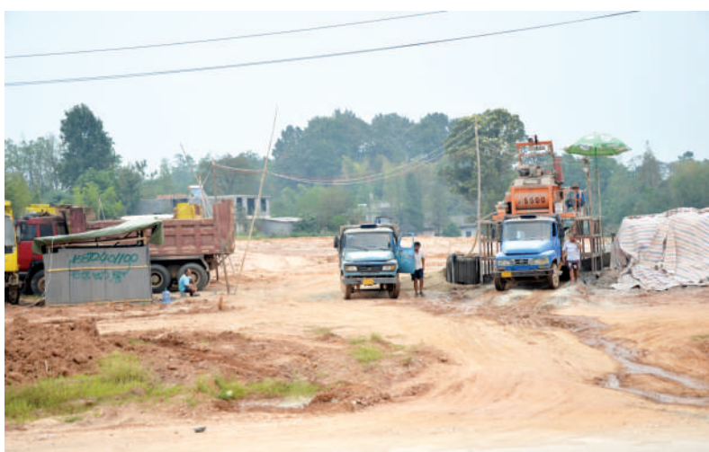
科瑞嘉机电施工现场
