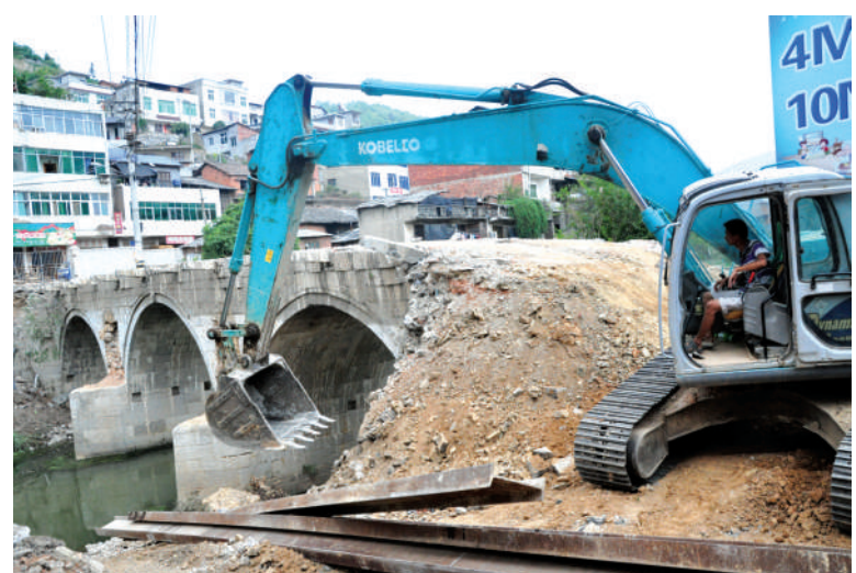
日前,通山县通羊镇马槽桥正在被拆除重修。始建于明朝末年的马槽桥,是连接该镇南北城区的重要枢纽。由于年代久远,破损严重,今年县政府把该桥重建改造作为重要民生工程之一,对其进行拆除重建。 通讯员 陈进 摄
