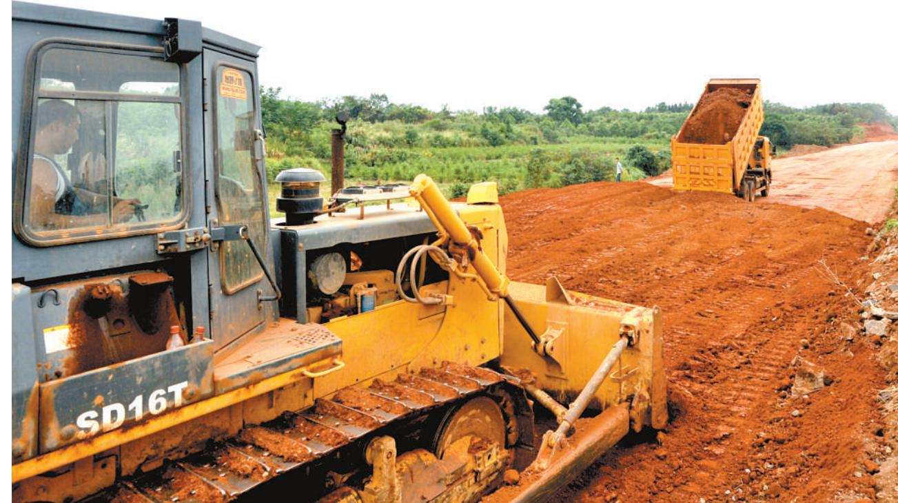
8月22日,嘉鱼县渡普镇咸潘一级公路任家桥至咸安连接点段,几台大型机械正在作业。据了解,咸潘一级公路嘉鱼段全长15.59公里,宽24.5米,设计标准为双向6车道。于今年4月动工,工期24个月,今年底将完成路基工程,预计2015年3月全线通车。
