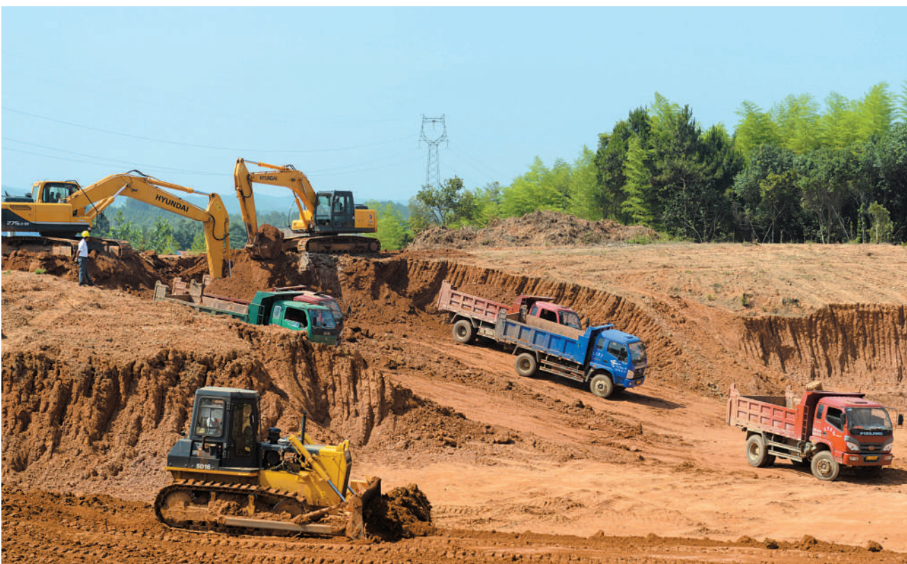
10日,王英水库供水工程正抓紧建设。该工程全长45公里,总设计规模20万方米/日,由取水泵站、输水管线、净水厂和配水管线组成,其中一期建设投资3.5亿元。该工程于今年5月开工建设,2015年12月可建成供水,届时我市城区供水紧张情况将得到彻底解决。 记者 袁灿 通讯员 方娇娅 摄
