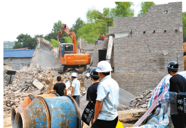
16日,市城管局、市、区控违办、公安局、浮山办事处等单位270余人,对咸安区浮山办事处大坂村五组违法建筑进行强制拆除。当日共拆除14户违法建设,拆除面积达1010平方米。据悉,浮山办事处大坂村五组是我市城中村改造的重点项目。
