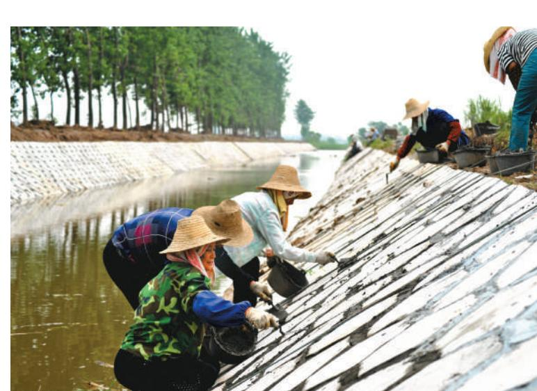
7日,嘉鱼县簰洲湾镇刘家堤村,工人们正在整修一新的灌溉渠坡面上贴六棱块。簰洲湾素有“水袋子”之称,去年,该县以国土整治项目为契机,整修灌溉渠。该渠完工后,全镇5万亩水田的灌溉将得到有效保障,达到旱涝保收。
