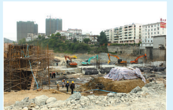
热火朝天的大坂陈闸施工现场
