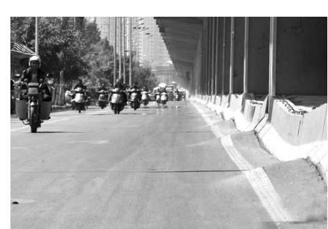
路面上桥墩处向上拱起,两桥墩之间的水泥隔离带下沉,整个路面呈起伏的“波浪”状。路面上的雨水井盖被挤压得严重变形,有的井盖高低不平达18厘米。而这样“波浪”型的路面不仅存在二环南路与气象路交叉口,还一直延伸至明波立交附近。
