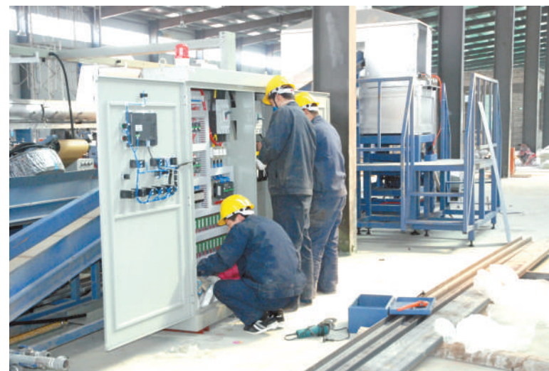
丰日电源设备调试中
