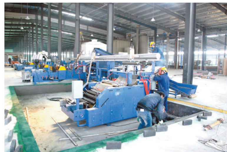
丰日电源车间设备安装现场
