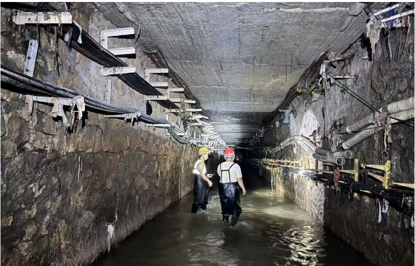
咸宁大道鄂高至水利局路段两侧老旧箱涵内管线规整前后对比
