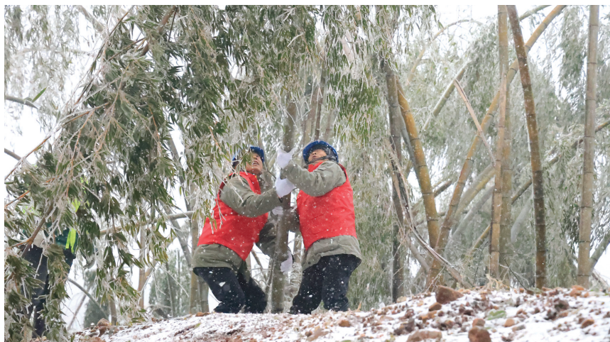
1月20日,国网咸宁市咸安区供电公司汀泗供电所在星星竹海对星星村、西关村用电线路上的覆冰、倒竹进行清理。(曹露)
