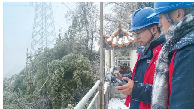
1月20日,国网咸宁供电公司检修分公司输电无人机巡检班利用无人机搭载除冰棒对220赤鸣线进行除冰。(郑喻)
