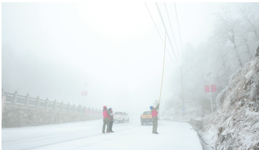
1月20日,国网通城县供电公司麦市供电所组织共产党员服务队在天岳关巡线,清除电线上厚厚的覆冰,确保冰雪冻雨天气下电网稳定运行。(杨微微)
