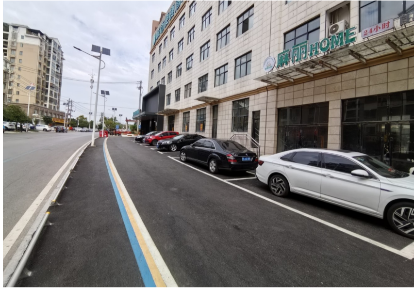
▲改造后的凯悦投资大厦停车场焕然一新、秩序井然
