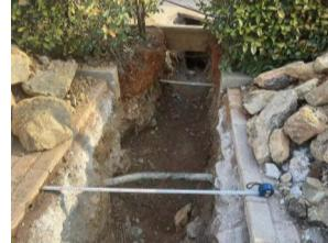
进行改造升级,加大雨水口与雨水井之间的连接管径,并采取放坡措施,解决了积水问题,也方便后期疏通。5月23日,该处排水管网改造完成。
