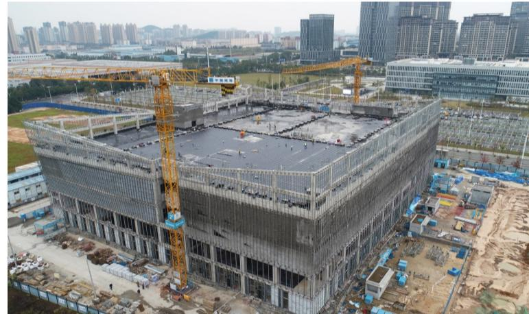
12月20日,记者在全市全民健身中心项目建设现场看到,目前大楼的施工围挡已经拆除,工人们正在进行外立面施工和屋顶球场防水作业。据了解,该项目紧邻市民之家,总面积2.7万平方米,项目主体建筑共四层,包括泳池、体育培训室、羽毛球室、乒乓球室、篮球室、屋顶足球场等。外场还将建设体育公园、健康步道、网球场等,预计2024年8月建成投用。
