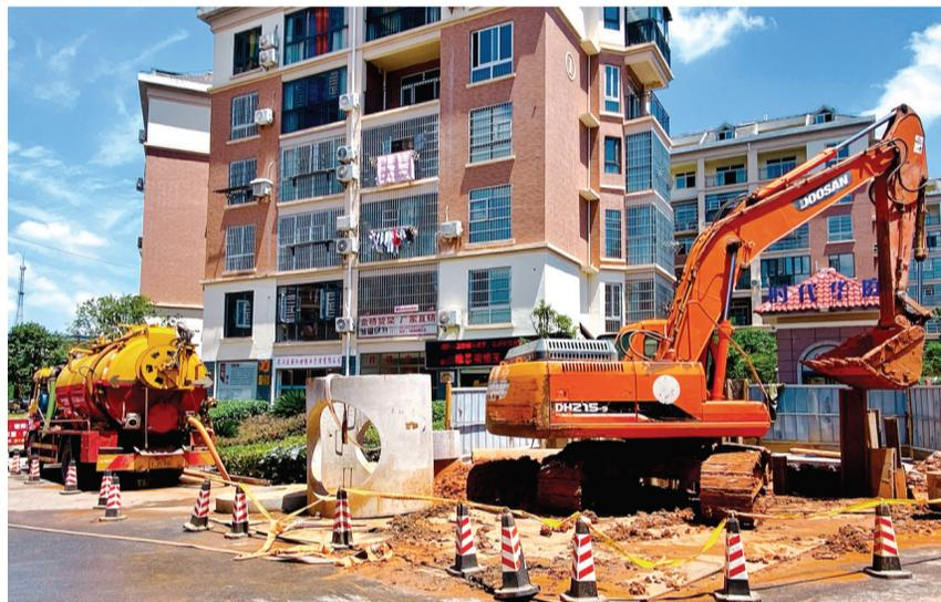
联合市城管执法委、市财政局、岔路口社区、市规划设计院等单位进行现场勘察,并委托市国土空间规划院对该处抢修工程进行方案设计。拟新建1座直径1.2米、深6米的圆形混凝土排水管道检查井,破除并恢复0.4米厚的现状混凝土
