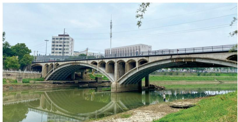
肋和拱腹加固,桥梁主体结构承载能力提升。
