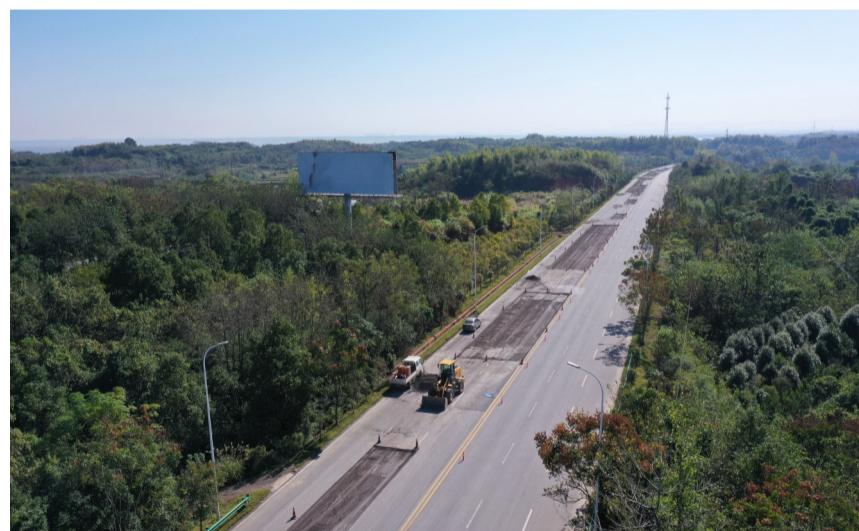
1月10日记者在G351台小线看到,养路工人们趁着大好天气,正在进行G351台小线北岭至高家岭段灾毁重建工程。该工程相关负责人介绍,由于以往途经的重型货车太多,导致路面出现多处开裂、凹陷和破损。“脱皮露骨”的路面对过往行人和车辆造成一定危险。据了解,此次修复路段约3公里,预计12月20日前全面完工,切实保障当地群众出行安全。
