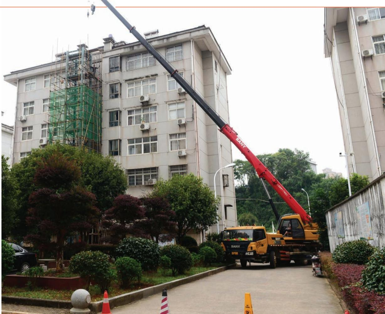
9月27日,记者在咸宁城区人事小区看到,小区2栋楼房架起了加装电梯钢结构,工人正在对其中一个钢结构施工。目前,该小区已完成架设2栋楼的加装电梯钢结构,剩下1栋的钢结构正在有序建设,下一步将进行玻璃幕墙建设。该小区加装电梯项目预计今年10月底完工,11月可投入使用。
