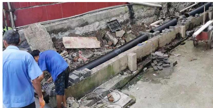
在此处埋设直径30厘米排水管道接入市政管网,同时建雨水收集口及挡水墙、硬化破损路面及巷道等等。
