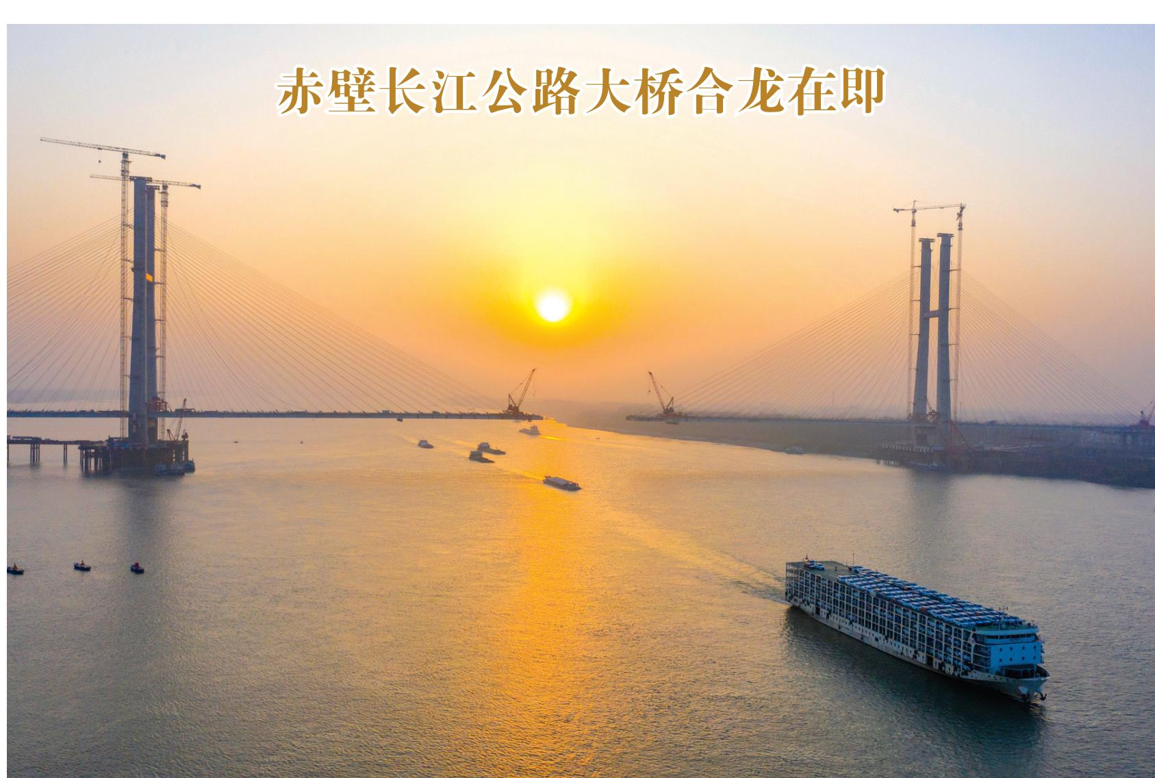
1月29日，赤壁长江公路大桥工地，工人们在紧张有序地施工。该桥南岸滩桥最后一孔50米的现浇箱梁已施工完毕。主跨桥梁也在不断的实现合龙，目前合龙距离还剩76米。预计今年三月底实现合龙。
