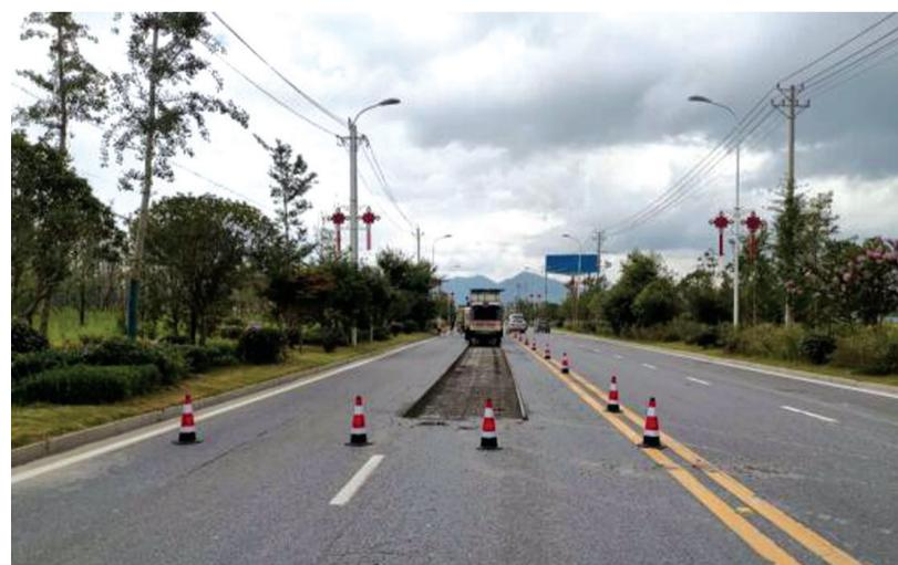
铣刨区域进行水稳铺设,打好基础。最后再进行沥青封层。整个作业过程各施工队伍分工明确、配合有序,作
