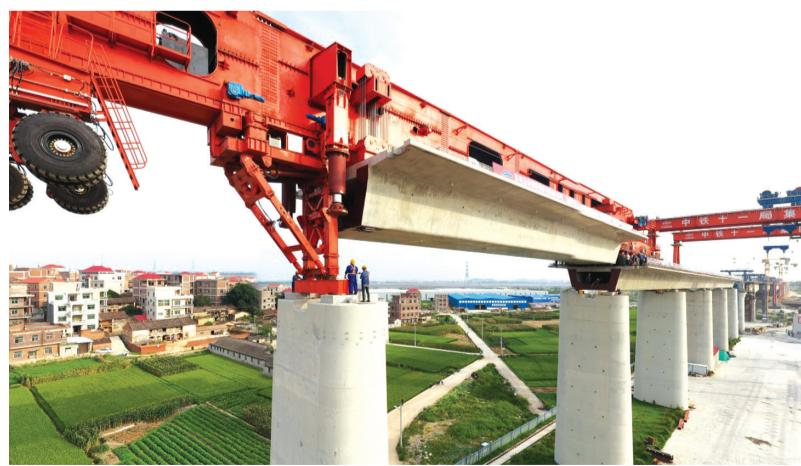
介绍,福厦高铁桥梁采用了1000吨级箱梁设计理念,相较于传统箱梁设计,占地面积减少20%,投资降低15%,尤其像湄洲湾这样的跨海大桥,1000吨级箱梁既增加了通航能力,又提高了跨海大桥的安全性。
