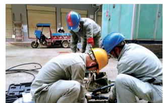
近日,国网咸宁通山县供电公司员工对10千伏城关线南门大院箱式变压器进行增容改造。据悉,原500KVA老旧箱式变压器严重腐蚀,已不能满足居民生产生活用电快速增长的需求。为提高迎峰度夏期间用电可靠性,满足夏季居民负荷增长的需求,供电所员工在该台区新装一台1250KVA箱式变压器,进一步提升设备承载负荷能力。(通讯员 艾丽丝)
