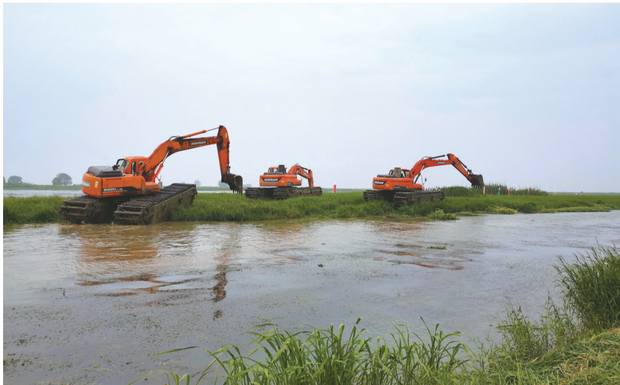
▲斧头湖淦河入湖口疏浚工程项目现场
