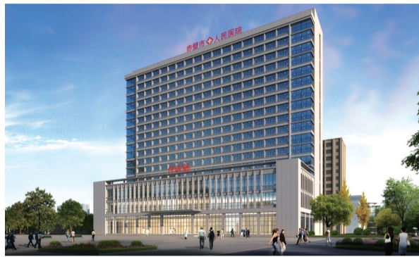
省级法治建设示范医院——赤壁市人民医院
