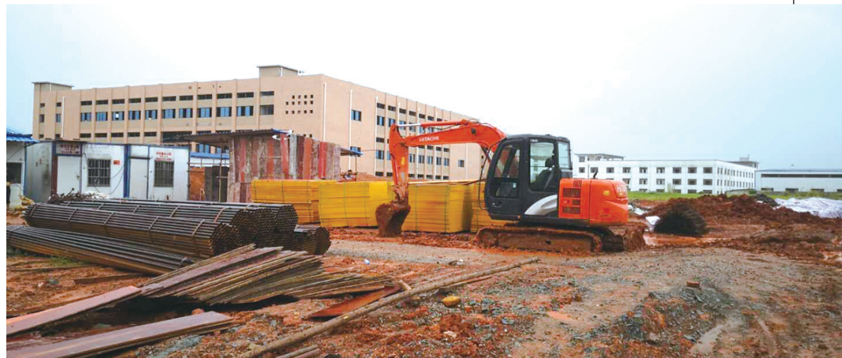
▲正在建设的湖北健翔生物制药有限公司
