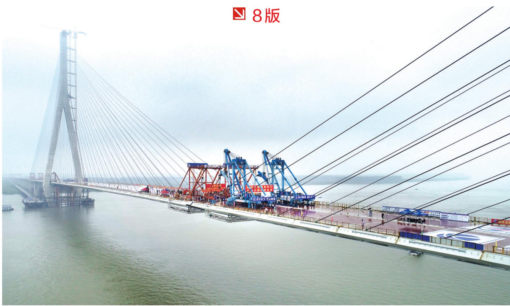
5月30日上午11时许,历时3年多建设,由湖北交投投资、中交第二公路工程局和四川公路桥梁建设集团参建的湖北嘉鱼长江公路大桥成功合龙。该桥于2016年2月23日开始动工,总投资31.44亿元,全桥长4660米,主桥为双塔双索面混合梁斜拉桥,长1650米,主跨920米,是世界最大跨径非对称混合梁斜拉桥。
