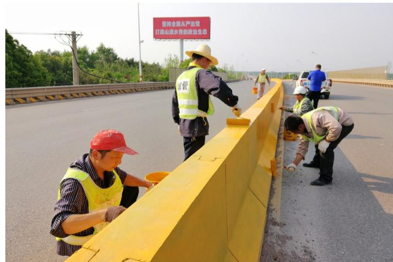
施,中央隔离墩安装工作已完成,共安装1450个。中央隔离墩正喷涂波导反光漆,可遮挡对面车灯光,警示过往车辆。另外,还配置道路反光地钉、反光标及地标黄线等防护警示设施,有效提高行车安全的同时,也达
