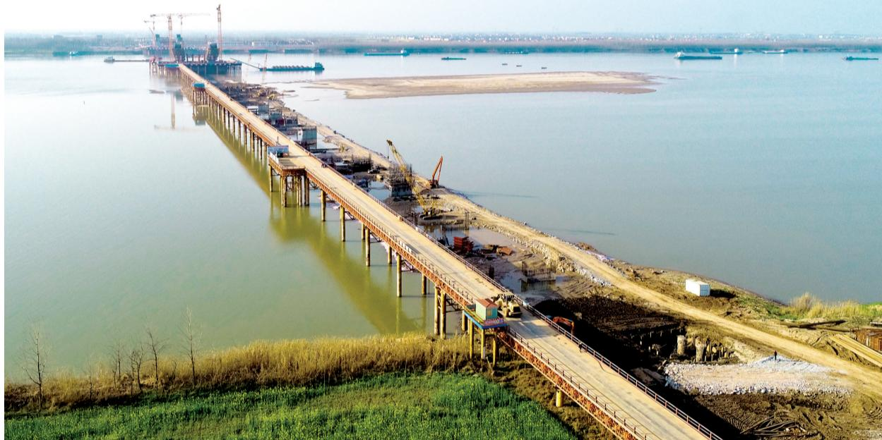
▲3月21日,赤壁长江公路大桥南岸,工人们抢抓时机施工。目前该桥南北主塔均进入下横梁施工阶段,滩桥和跨堤桥下个月开始转入上部结构施工。
