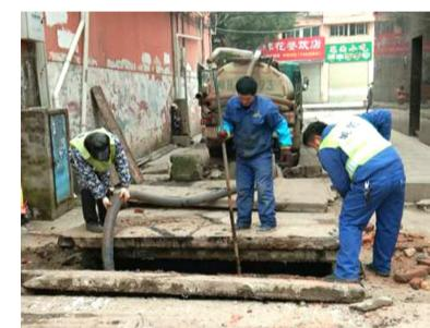
车,在完成粪便清理、管道疏通后,将恢复水泥路面,并重建检查井2个,预计一个星期完成施工。
