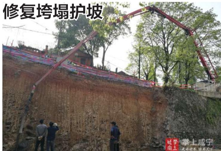
昨日,市城管执法局市政管理处组织施工人员对温泉城区八一巷一处垮塌护坡进行修复。该处长约20米、高6.3米的护坡由石头砌成,因雨水长期冲刷,导致垮塌,存在较大的安全隐患。
