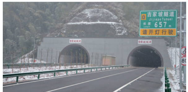
武深高速赤壁吉家坡隧道
